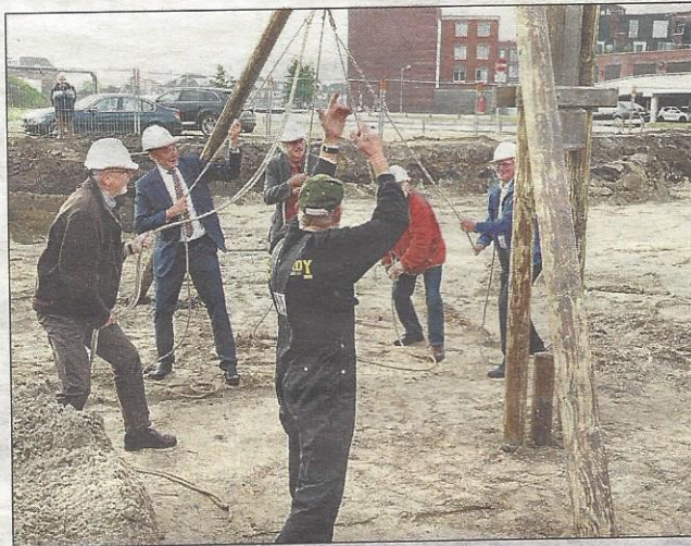
De eerste paal wordt de grond ingeslagen.
